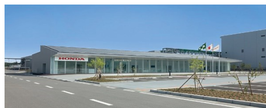
ホンダ寄居完成車工場
