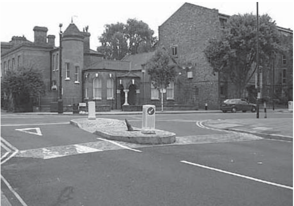
写真2：写真1の交差点を別の角度から捉えている。横断歩道部分が盛り上がりハンプの機能を兼ねている
