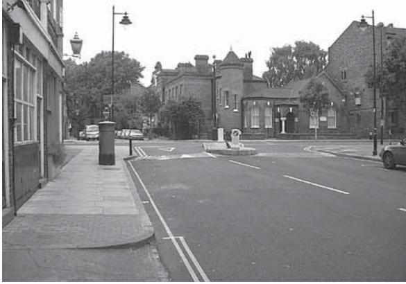
写真1：ロンドンの住宅地の典型的な交差点。中央分離帯と車道幅が手前から狭められているのが特徴だ。また減速の為のハンプを備えている
