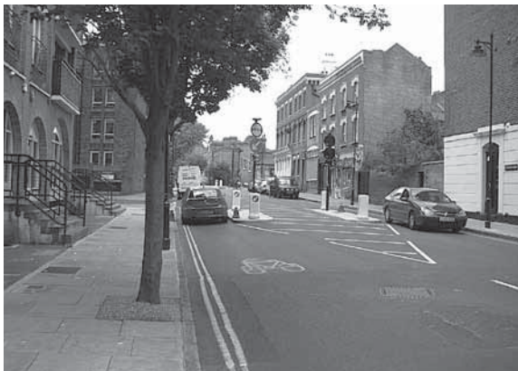
写真3：写真1の交差点を手前から見た写真。直線区間でありながら、車道幅を人工的に絞り込み、住宅地内における自動車のスピードを強制的に抑えている
