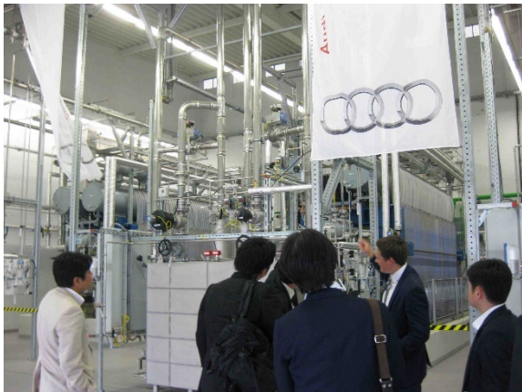
Audiのe-gas工場の電気分解槽を見学する視察団メンバー
