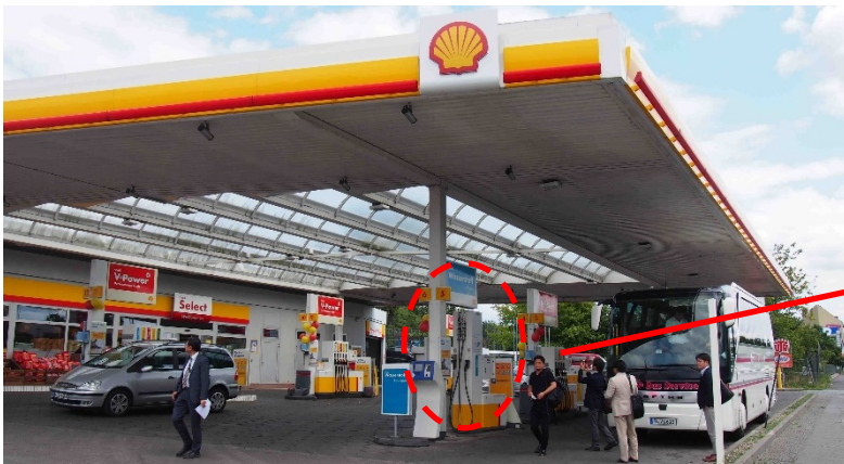
ガソリンスタンドに併設されているセルフ式水素充填機（写真中央手前）。ガソリン給油機と並んで設置されている。
