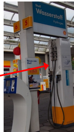
ガソリンスタンドに併設されているセルフ式水素充填機（写真中央手前）。ガソリン給油機と並んで設置されている。
