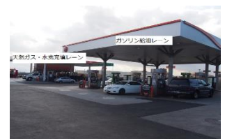
▲水素充填機は天然ガス充填機のすぐ隣にあり、水素は天然ガス同様の扱い
